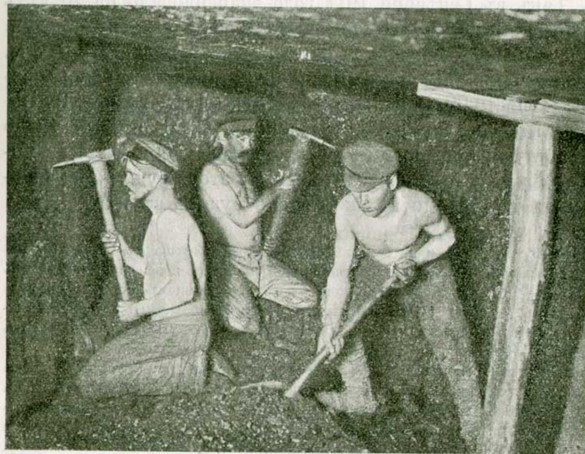
Отбойка угля въ пластѣ средней мощности. Столбовая система.
