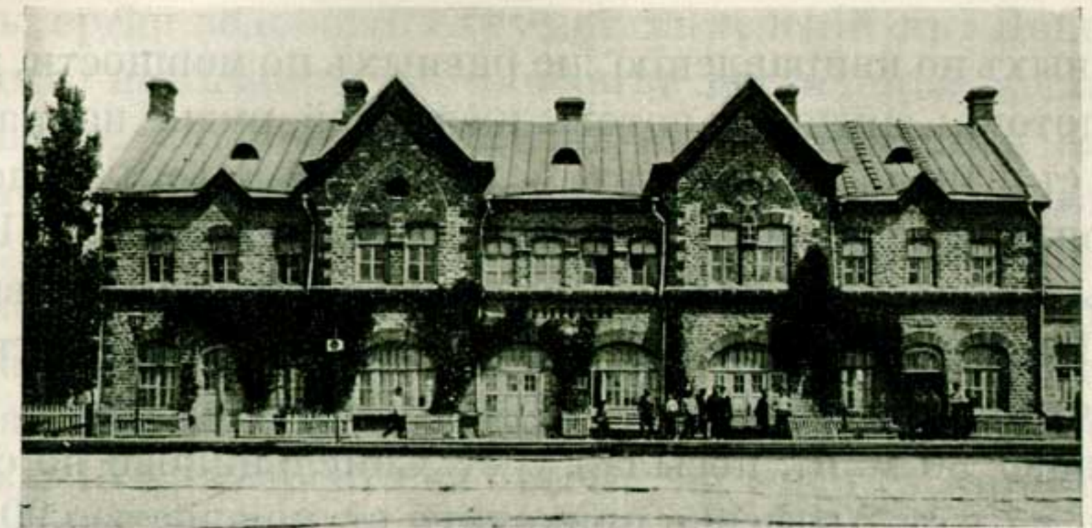
Пассажирское зданіе ст. Очеретино.
