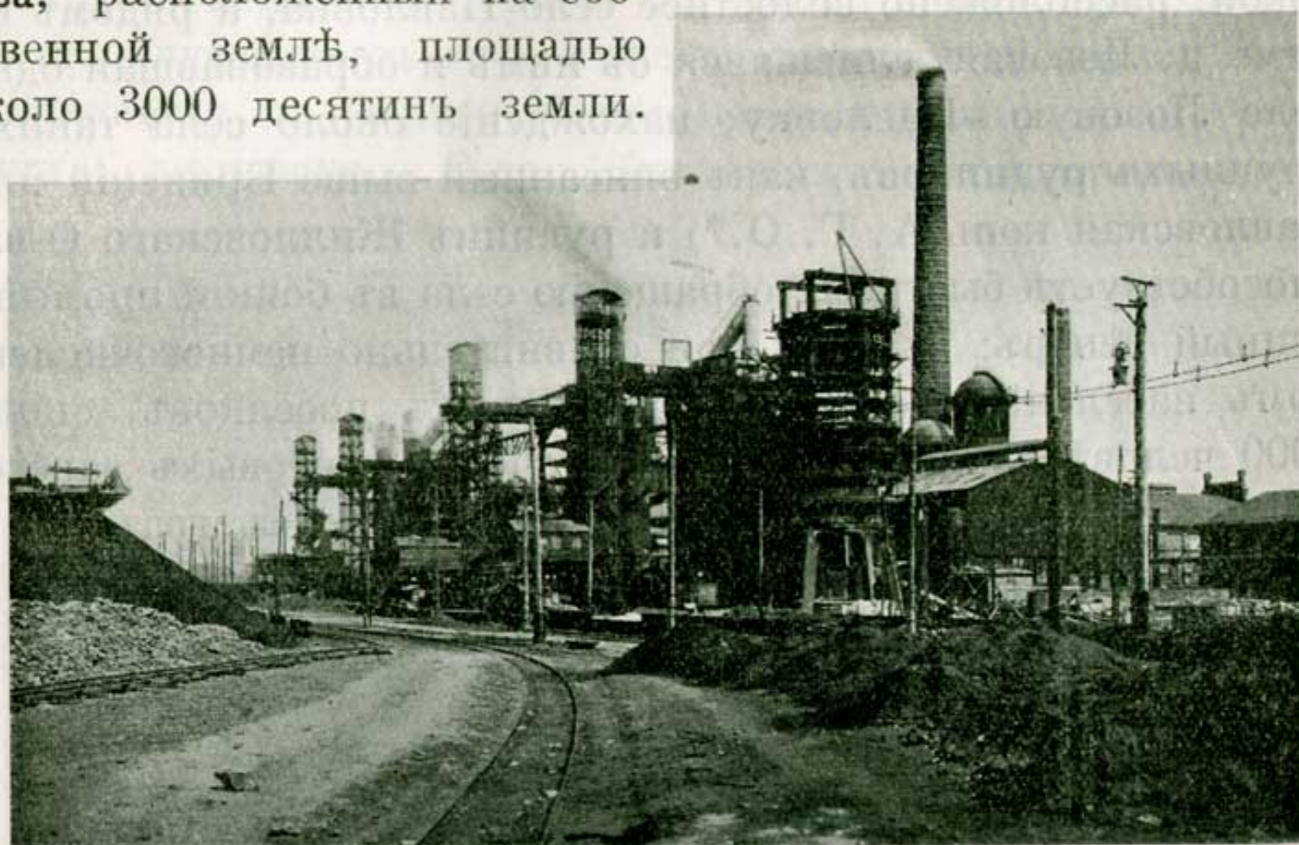
Доменные печи Донецко-Юрьевского завода.
