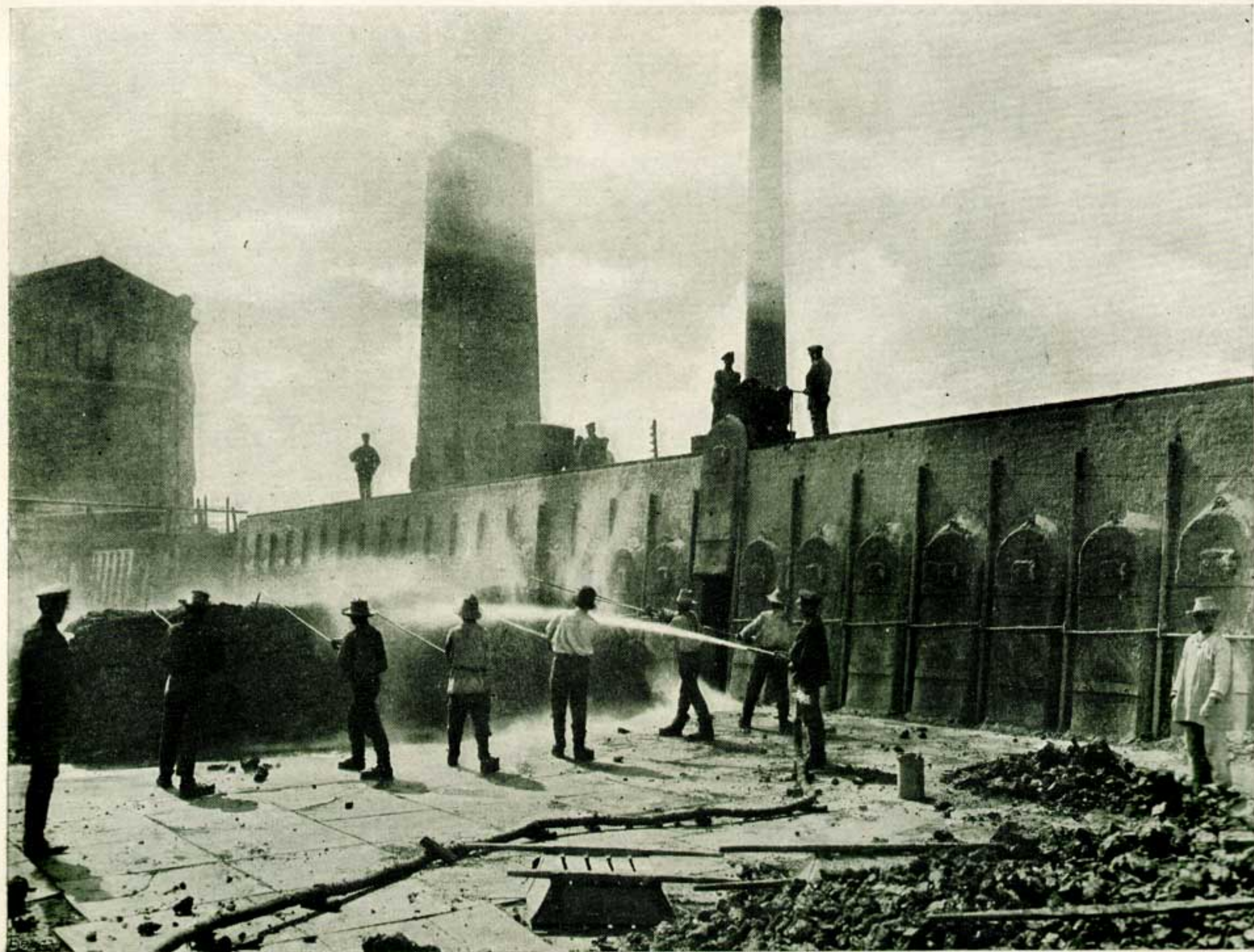
Коксовое производство. Охлаждение раскаленного кокса.
