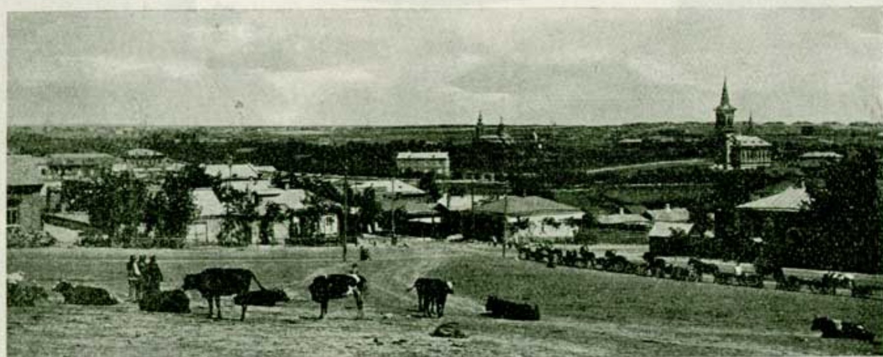
Поселокъ при заводѣ Русс.-Бельг. Металлург. О-ва.
