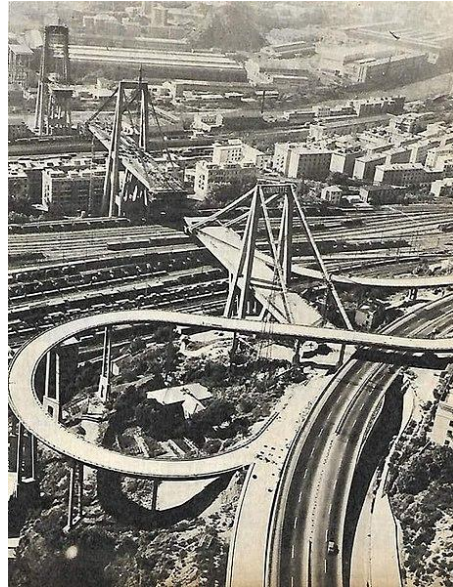
Costruzione Viadotto Polcevera, Genova, 1966. https://commons.wikimedia.org/wiki/File:Costruzione_Viadotto_Polcevera_1966.jpg
