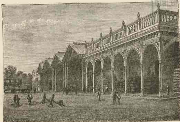
SANTIAGO. — Vista interior de la estacion de los ferrocarriles.
