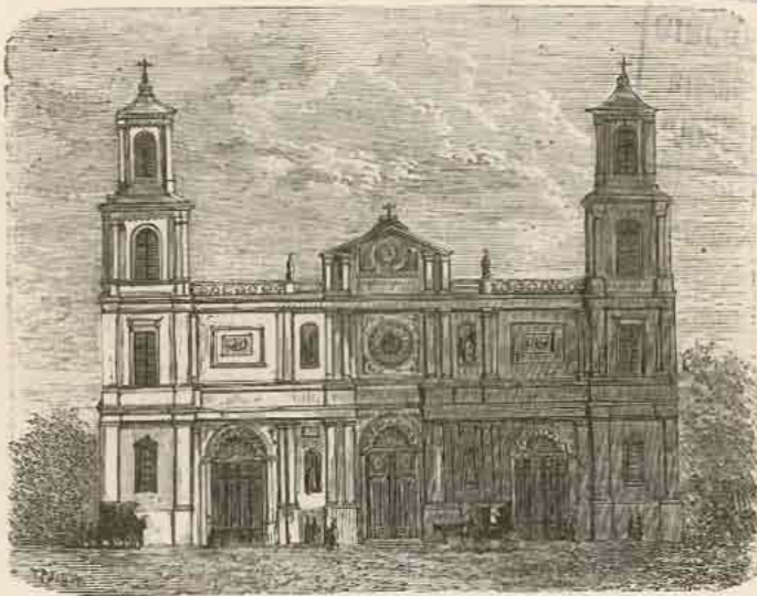
CAUQUENES. — Iglesia Matriz en construcción.
