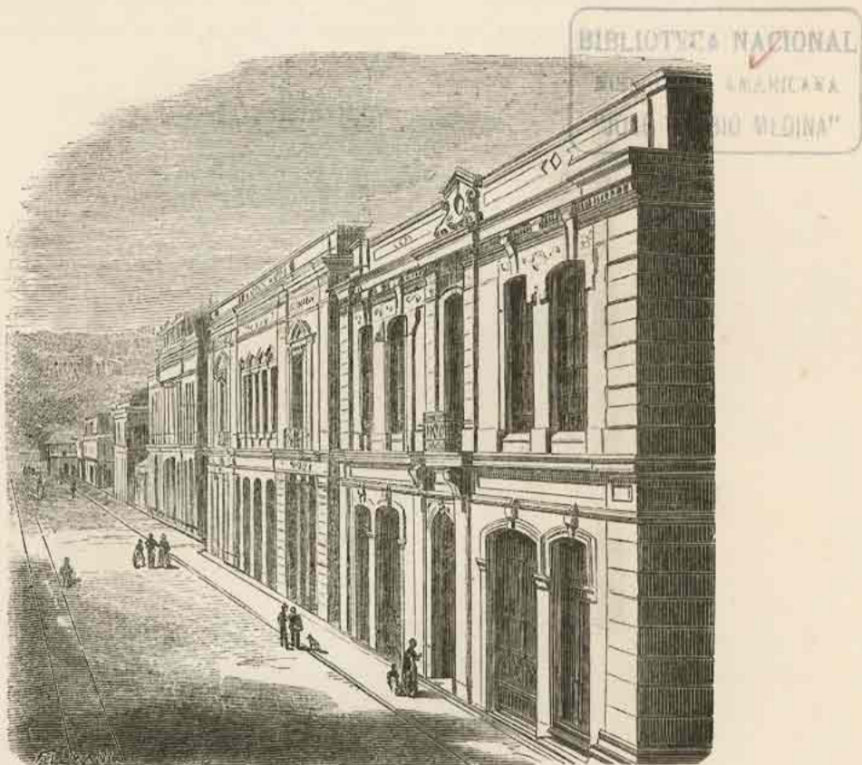
VALPARAISO. — Calle de la Planchada, costado Norte.
