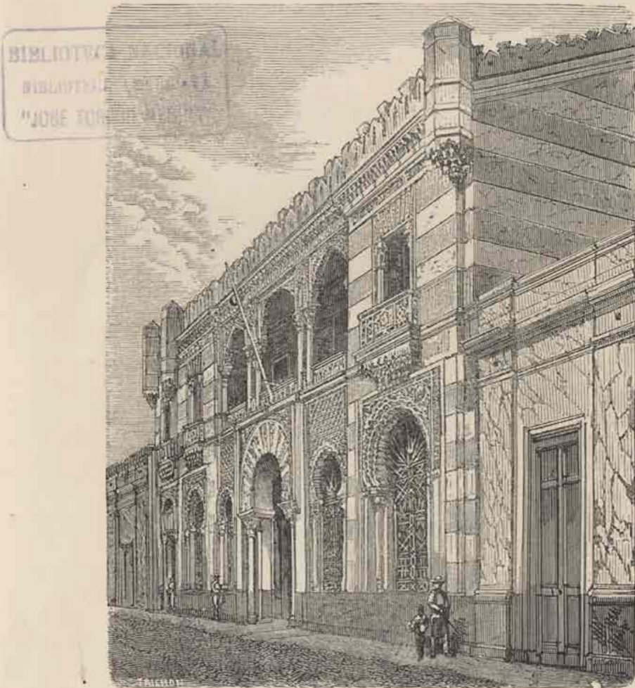
SANTIAGO.—Exterior de la casa de D. F. I. Ossa.
