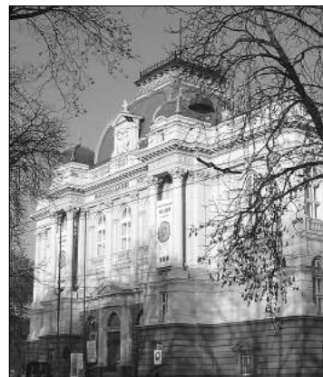
Будинок Національного музею у м. Львів по вул. Свободи, 20. Фото 2005.
