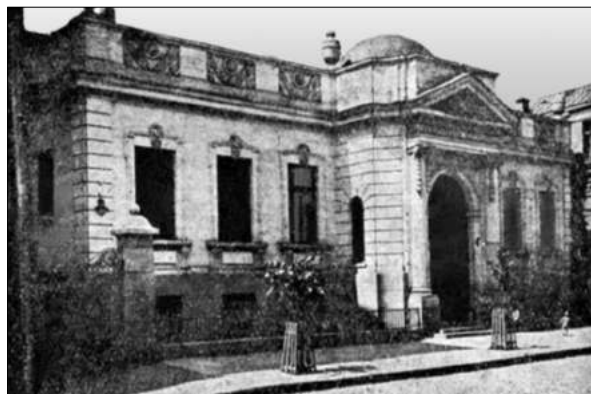
Будинок, де розміщувалася Науково-дослідна кафедра марксизму-ленінізму при ВУАН у м. Київ по вул. К.Лібкнехта, 12 (нині вул. Шовковична, 14). Архітектор Р. Мельцер. Фото 1930.
