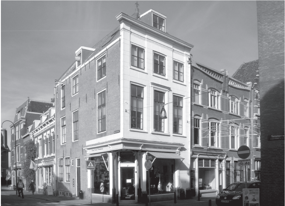
Suikerraffinaderij De Raapkoek en De Wildeman stond in een L-vorm om dit pand op de hoek van de Voorstraat met de Boomstraat heen (foto: J.W. Boezeman).
