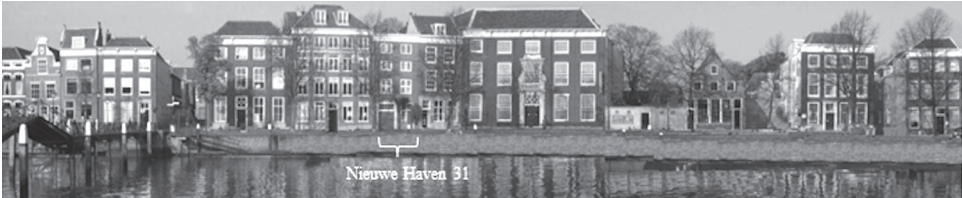
Fotomontage van de vroegere raffinaderij in de gevelrij van de Nieuwe Haven (boven) en de bestaande situatie (onder) (fotomontage: J.W. Boezeman). 3
