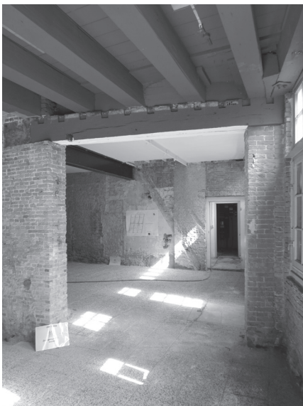
Interieurfoto's begane grond in de huidige toestand (foto's: C. Sigmond) en geveltekening (2012) t.b.v. de verbouwing.
