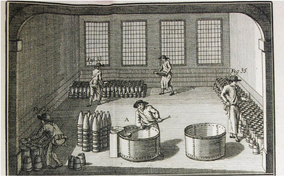
Afbeelding van het Vulhuis in eene Raffinaderij, en van eenige verschillende verrichtingen in hetzelfde. (uit: Reisig, De suikerraffinadeur ). Fig. 32. Een Werkman, die de vormen zet om gevuld te worden. Fig. 33. Een ander, die de vormen vult. Fig. 35. Een ander die de broeden roert. A. Een ander, die het afdraagbekken vult.
