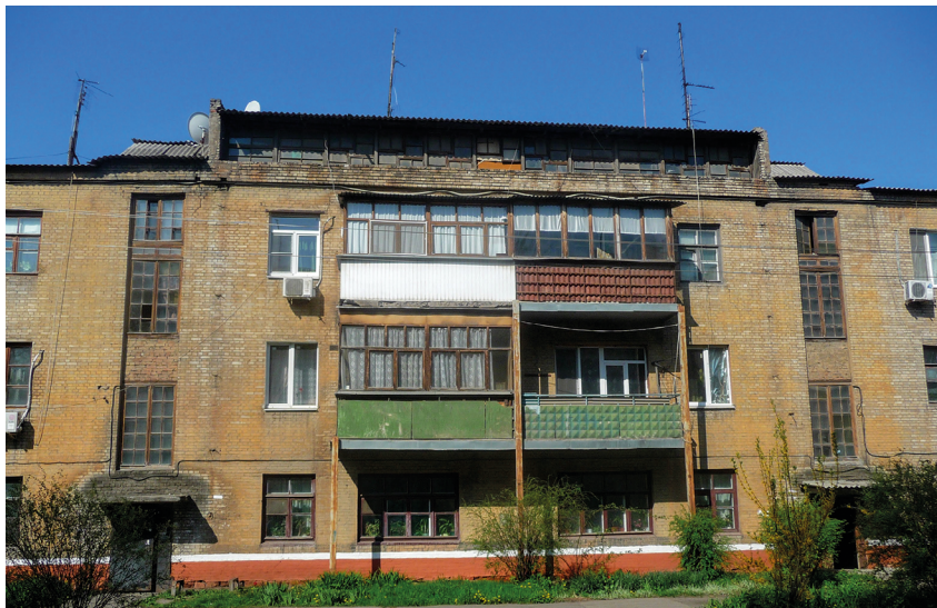
Іл. 9. Одна з двох мансардних надбудов житлового будинку по вул. Велика Садова, 73 («Американський будинок»), м. Краматорськ. Сучасний вигляд. Фото з відкритих джерел.
