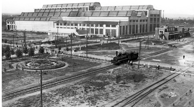
Іл. 31. Механоскладальний цех «А», Новокраматорський машинобудівний завод, м. Краматорськ. Фото 1932 року з вебсайту «The Constructivist Project».
