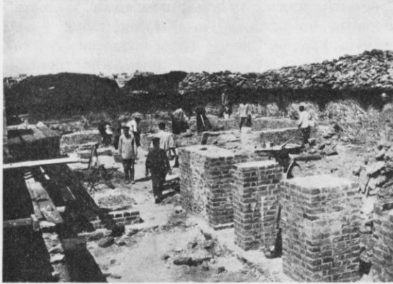
Рис. 12. Главное зданіе Станціи. Начало каменныхъ работъ въ общемъ котлованѣ; наружныя стѣны отъ основанія до поверхности земли выложены изъ „дикарнаго камня“ на известковомъ растворѣ; отвѣтственные, сильно нагруженные столбы между дверными пролетами, — изъ кирпича на смѣшанномъ растворѣ. По крайямъ котлована, кромѣ чернозема, расположены кучи дикаря, извлеченнаго при выемкѣ и употребленнаго на кладку стѣнъ.
