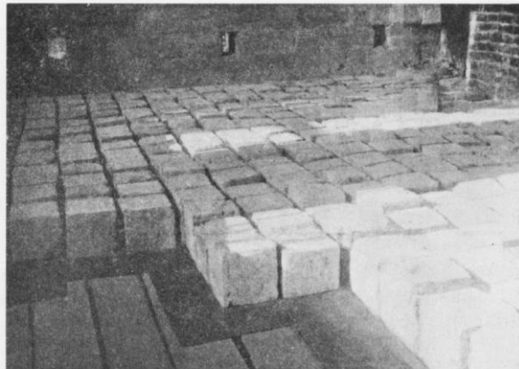
Рис. 16. Главное здание Станціи. Устройство плоскаго каменнаго перекрытія надъ нижнимъ этажемъ. По плоской досчатой палубѣ (передній планъ) постлана оберточная бумага и поверхъ ея уложены кубической формы камни, выпиленные изъ „пятерика“; швы камней всюду совпадаютъ. Послѣ укладки камней въ швы будутъ проложены желѣзные круглаго сѣченія стержни ( d = 10 мм.) и налить жидкій цементный растворъ (оберточная бумага предохраняетъ протеканіе раствора сквозь щели досчатой палубы). По прошествіи 1½–2 недѣль палуба, укрѣпленная на подклиненныхъ стойкахъ, снимается.
