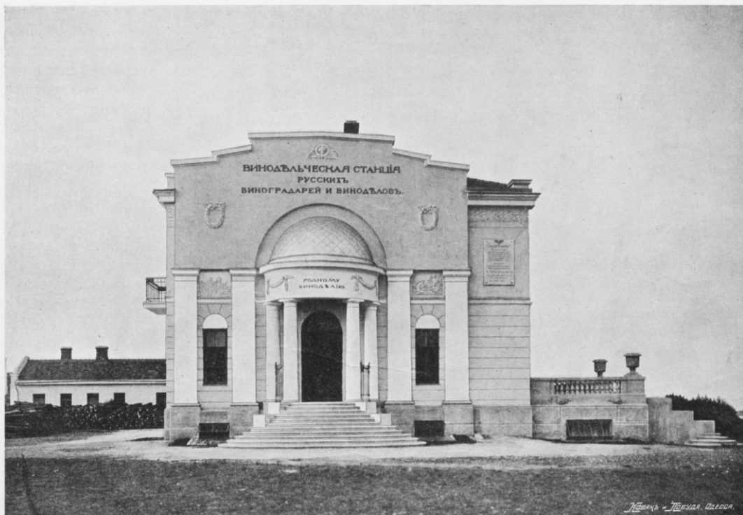
Рис. 17. Главное здание Станціи. Фасадъ къ дорогѣ-улицѣ (по фотографіи съ натуры).
