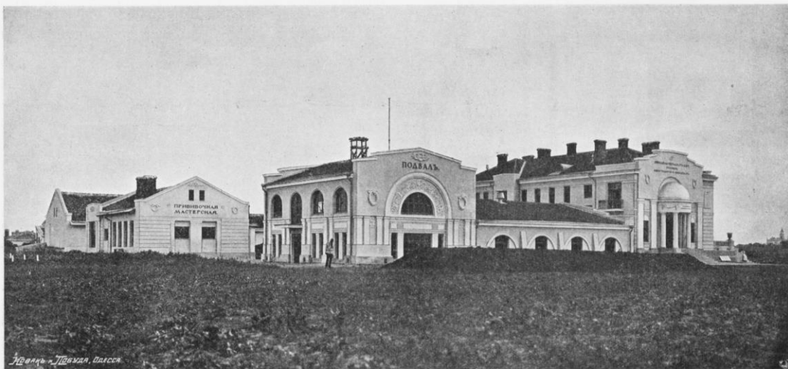
Рис. 65. ОБЩІЙ ВИДЪ ГЛАВНЫХЪ ЗДАНІЙ СТАНЦІИ. Справа налѣво: главное зданіе научныхъ учреждений и квартиръ высшаго персонала; подвалъ; прививочная мастерская и за ней—сарай для орудій.
