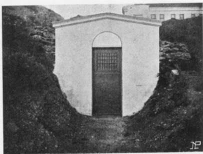
Рис. 51. Подвал Станции. Место выхода подземной вентиляционной галереи в окончательномъ видѣ, съ приспособленіемъ двойныхъ дверей (железной — снаружи и деревянной).
